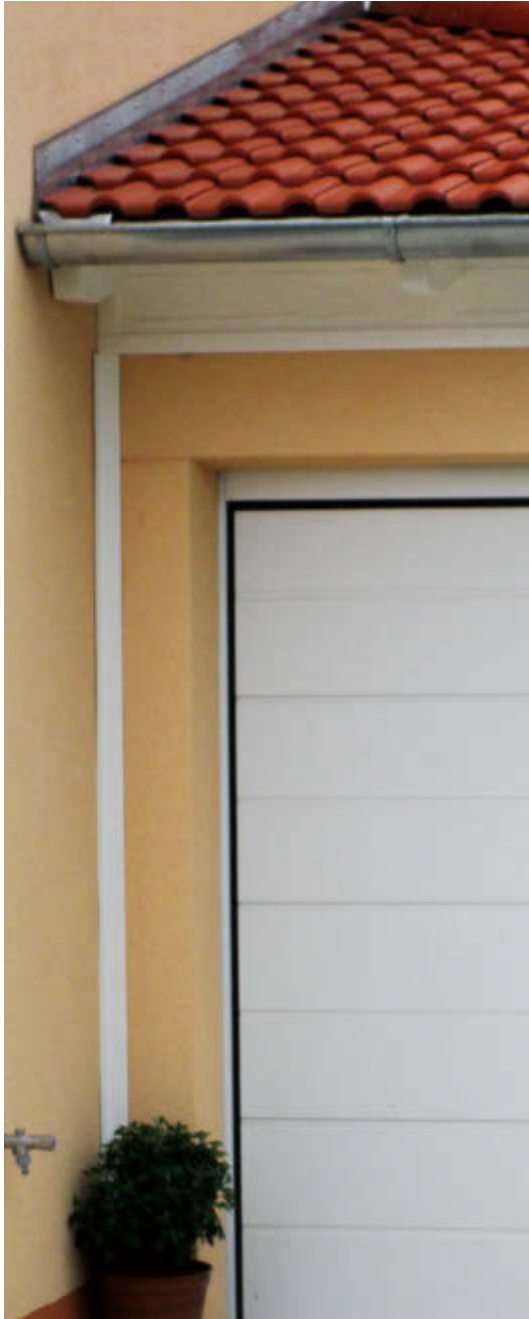
PVC-Eckfugenprofil als Anschluss zum Gebäude
