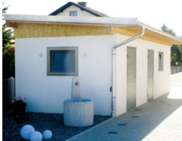
Pultdach mit Blecheindeckung
