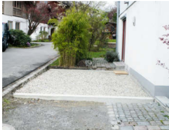
Streifenfundament für Einzelgarage
