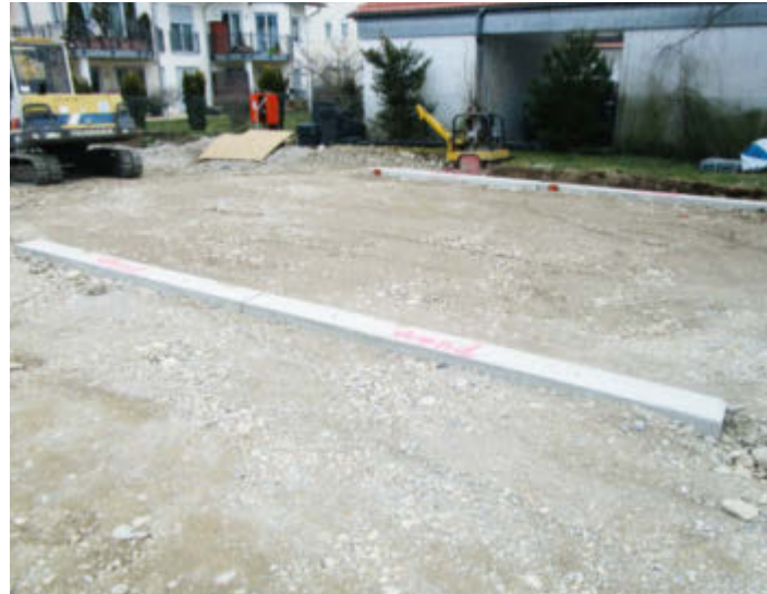
Streifenfundamente für zwei Einzelgaragen
