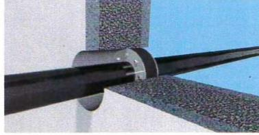
5. Dichteinsatz mit der ganzen Dichtbreite wandbündig zur Gebäudeaußenseite (Beton) Wasserseite einschieben.
