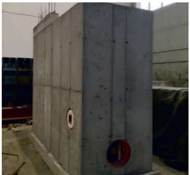
Maßanfertigung mit einer Systemschalung in druckwasserdichter Ausführung
