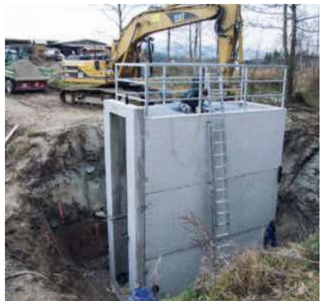
Brunnenschacht Kleinhöhenrain in Feldkirchen-Westerham mit aufgesetztem Technikraum
