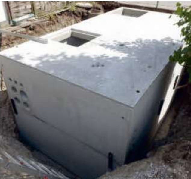
Technikschacht aus 2 monolithischen Schalen, die mit Dichtband wasserdicht verbunden sind
