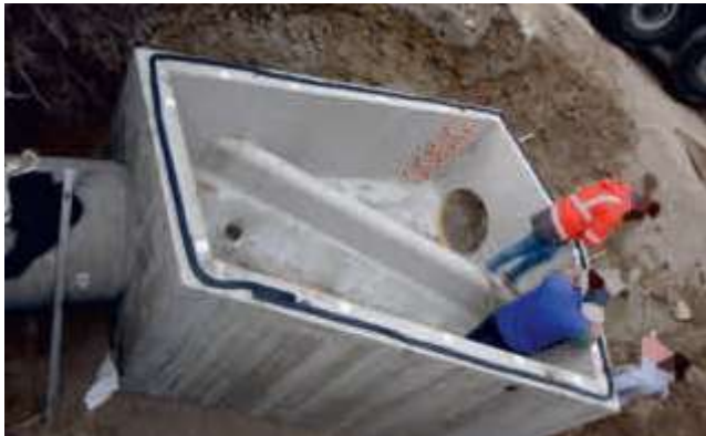
Trennbauwerk in Miesbach
