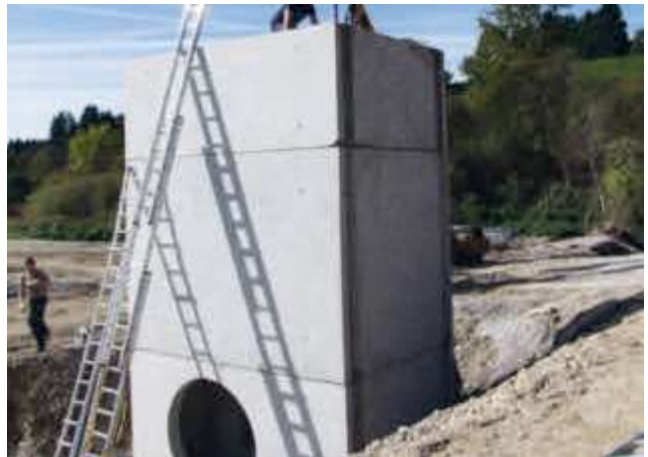
Auslaufbauwerk in Bad Endorf
