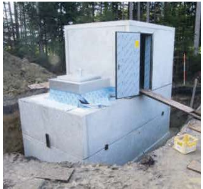
Brunnenschacht Kleinhöhenrain in Feldkirchen-Westerham mit aufgesetztem Technikraum
