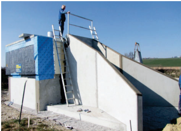
Brunnenschacht in Haag
