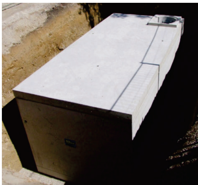
Monolithisch hergestellter Stahlbetonrechteckschacht mit verschiebesicherer Abdeckplatte durch Falzausbildung
