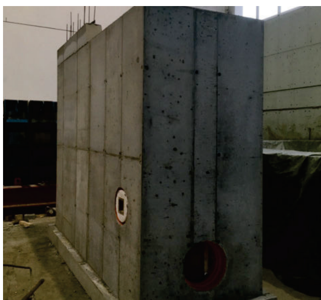
Maßanfertigung mit einer Systemschalung in druckwasserdichter Ausführung
