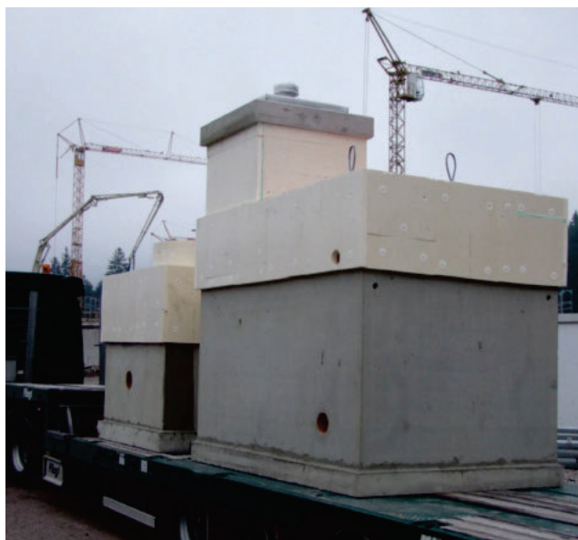
Stahlbetonschächte einbaufertig geliefert mit Dämmung bis ca. 1,0 m unter GOK
