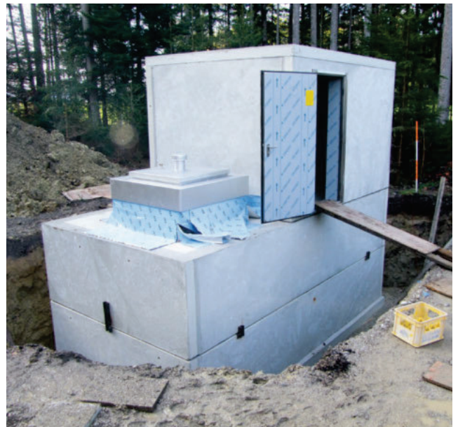
Brunnenschacht Kleinhöhenrain in Feldkirchen-Westerham mit aufgesetztem Technikraum
