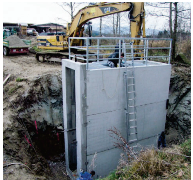
Brunnenschacht Kleinhöhenrain in Feldkirchen-Westerham mit aufgesetztem Technikraum
