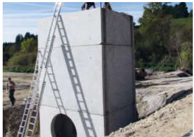
Auslaufbauwerk in Bad Endorf
