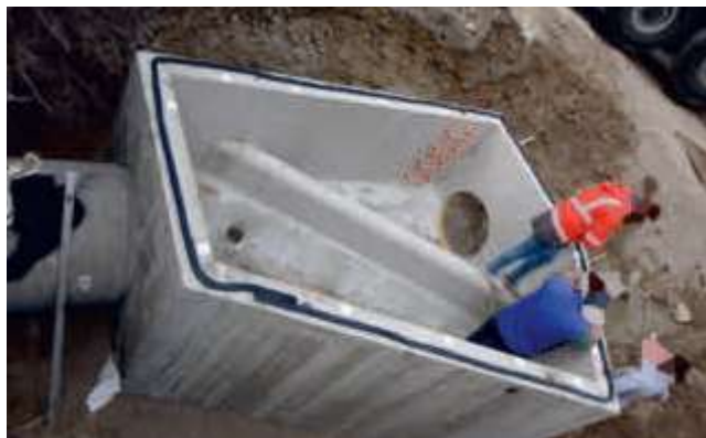
Trennbauwerk in Miesbach
