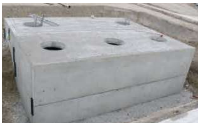
Rigolenanschlussschacht für MAN in München
