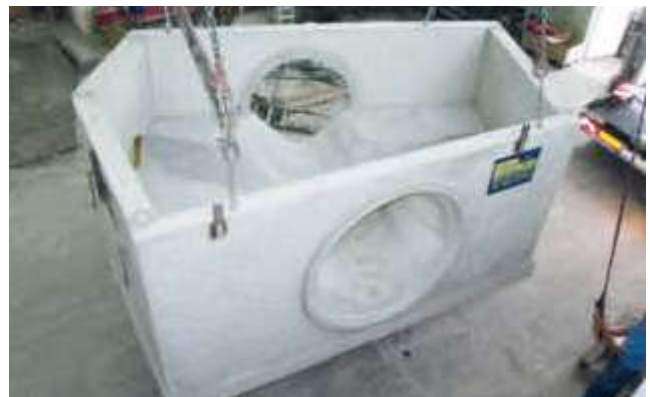
Zulaufbauwerk in Wasserburg
