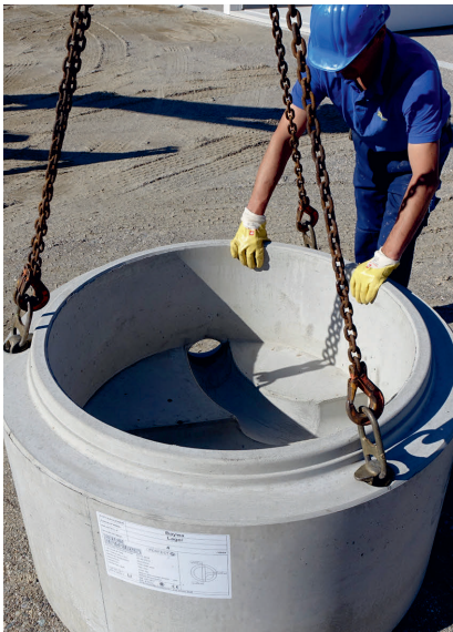
Schachtunterteil setzen.....
