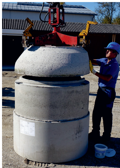
Schachthals aufsetzen.... (auf vertikale Anordnung der Lastübertragungselemente achten!)
