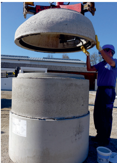
IDLA-Schachthals mit Gleitmittel versehen.....
