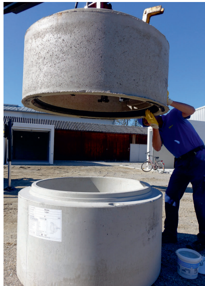
IDLA-Schachtring mit Gleitmittel versehen.....
