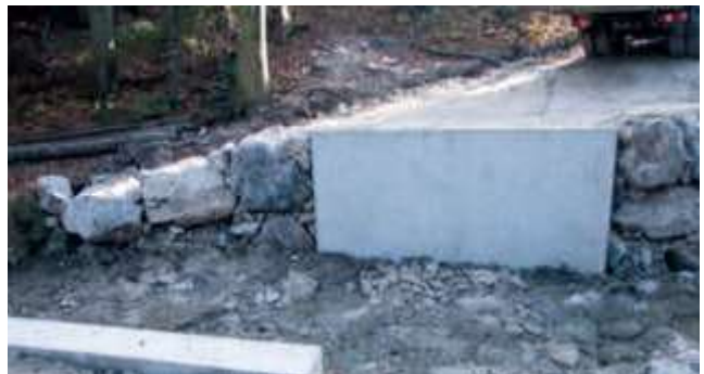
Hinterfüllung der Widerlager, Bachausbau
