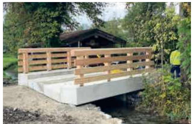
kurze Bauzeit durch Vorfertigung
