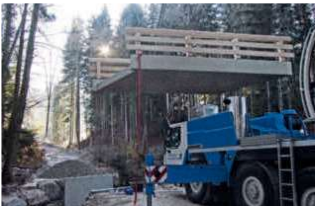
Versetzen der einteiligen Brückenplatte
