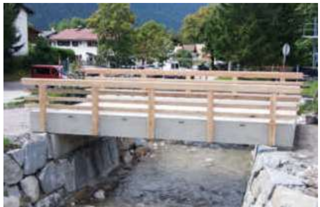
82487 Oberammergau/Brücke über die Große Laine
