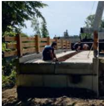
Plattenstoß mit Verschlaufung
