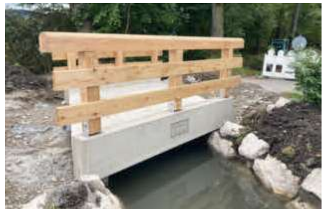
fertig montiertes Geländer in Balkenschuhen
