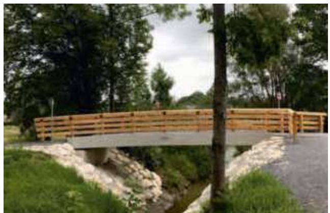
und optisch ansprechendem Lärchengeländer
