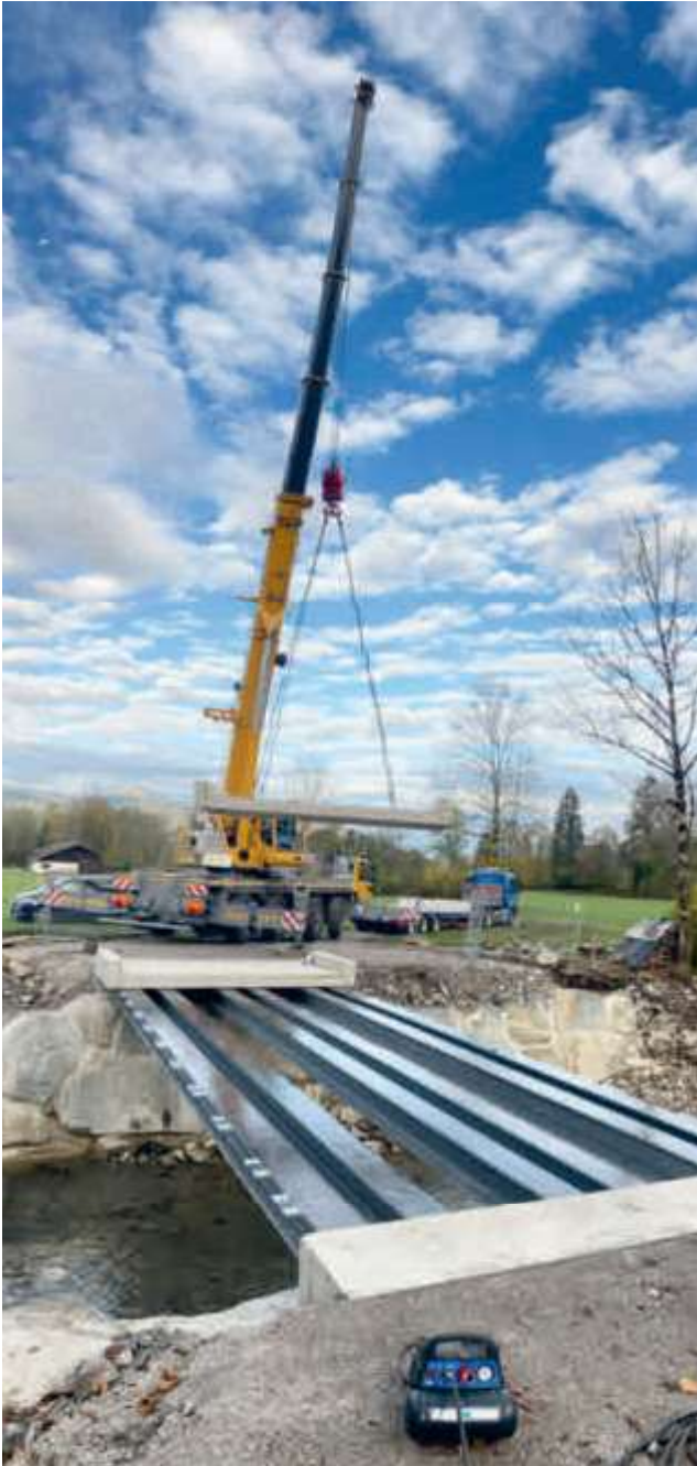
Oberbau aus 6 Fertigteilelementen
