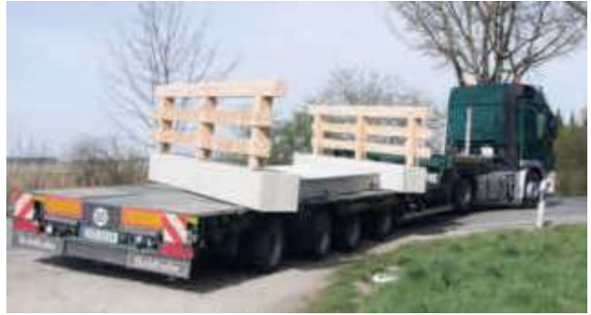
Anlieferung der kompletten Brückenplatte
