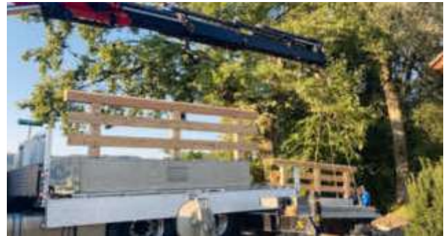
Anlieferung der Brückenplatte
