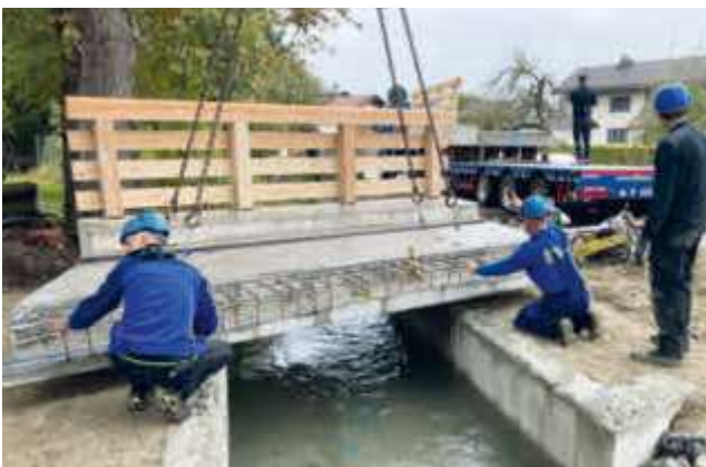
Versetzung auf Mörtelbett für Lastausgleich
