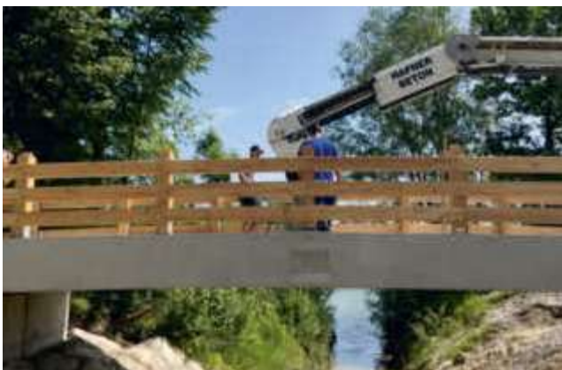
Brückenplatte mit Überhöhung, Jahreszahl
