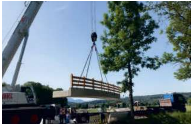
Versetzung mit dem Autokran...
