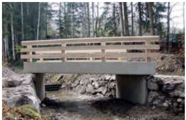
Spannweite 437 cm, Fahrbahnbreite 300 cm, Kreuzungswinkel Bach / Straße 66°
