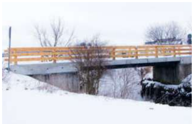
83043 Bad Aibling, Glonnbrücke bei Holzhausen
