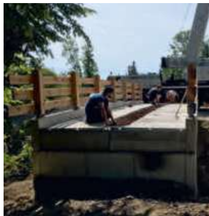
Plattenstoß mit Verschlaufung
