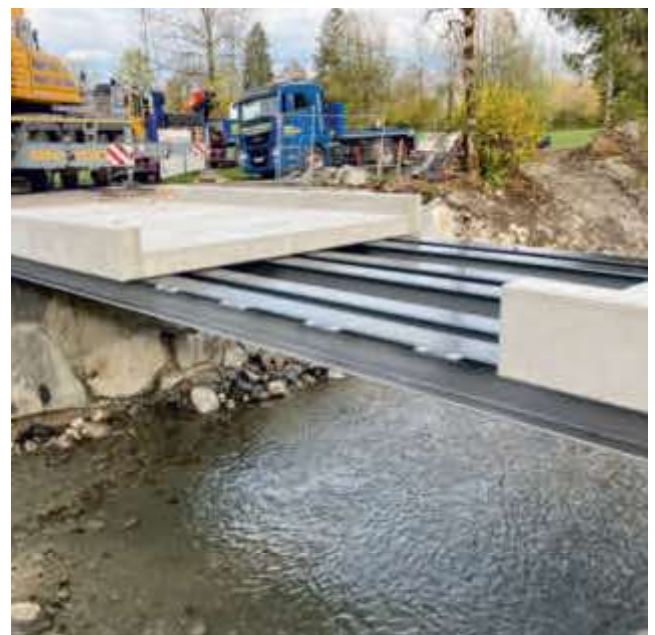
mit beidseitigem Schrammbord und Besenstrich
