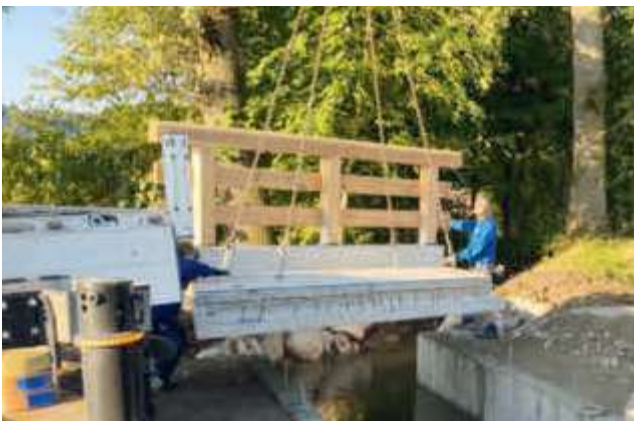
Versetzung mit Autokran oder Kran-LKW
