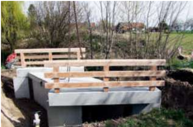
Spannweite 192 cm, Fahrbahnbreite 350 cm
