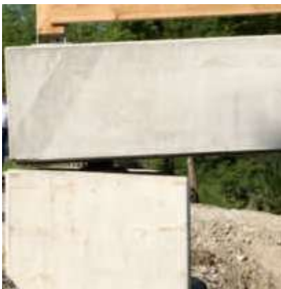
...auf Fundamente mit Brückenlager
