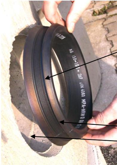
Die Keildichtung ist mit dem Anschlag nach außen in Richtung der Rohrtrasse einzubauen.
