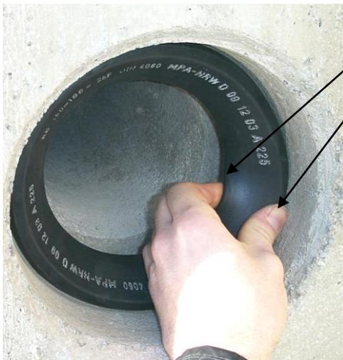
Die Keildichtung ist anzusetzen, die Innenseite hochziehen und die Dichtung mit den Fingern bzw. Handballen bis zur Betonaufkantung vorschieben.
