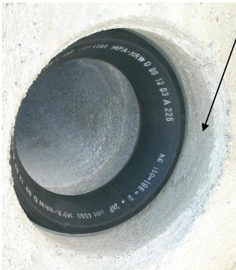
Um die Dichtheit zu erreichen muss die Dichtung gepresst werden, dadurch ist das Einführen des Rohres erschwert. Mit gängigen Hilfsmittel z.B. Hebelwerkzeugen ist das einschieben kein Problem.
