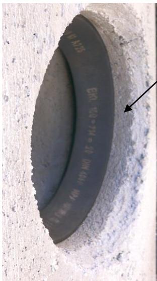
Um die Dichtheit zu erreichen muss die Dichtung gepresst werden, dadurch ist das Einführen des Rohres erschwert. Mit gängigen Hilfsmitteln z.B. Hebelwerkzeugen ist das einschieben kein Problem.
