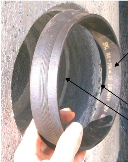
Die Keildichtung ist mit der schmalen Keilseite nach außen in Richtung der Rohrtrasse einzubauen.
