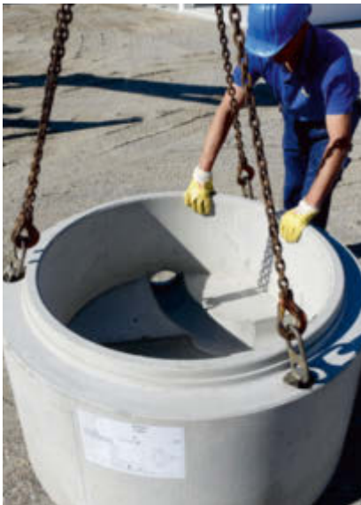
Schachtunterteil setzen.....
