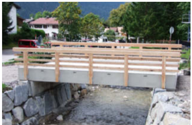
82487 Oberammergau/Brücke über die Große Laine
