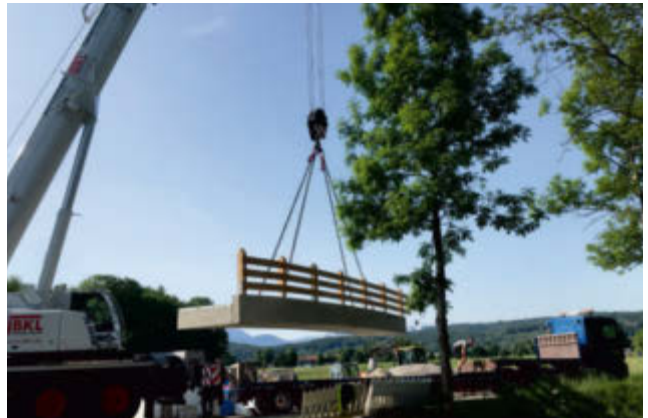
Versetzung mit dem Autokran...
