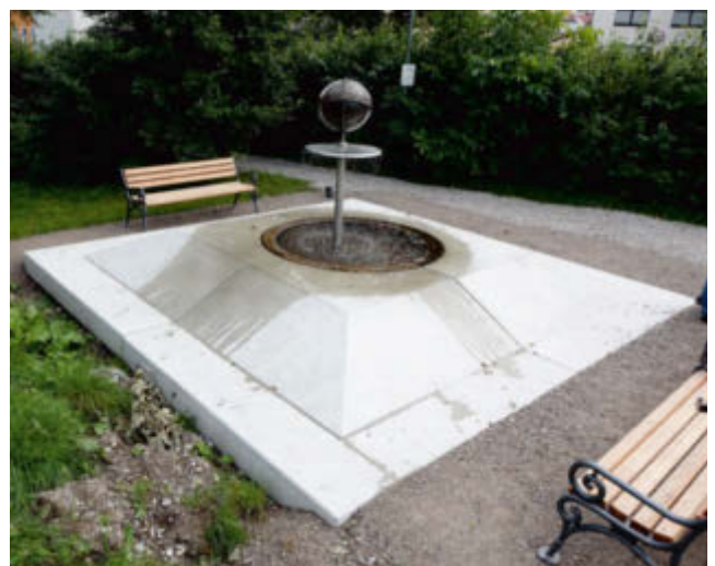
Brunnen in Sichtbeton
