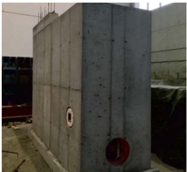
Maßanfertigung mit einer Systemschalung in druckwasserdichter Ausführung
