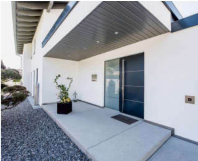
Eingangsbereich mit großen Betonplatten gestraht
