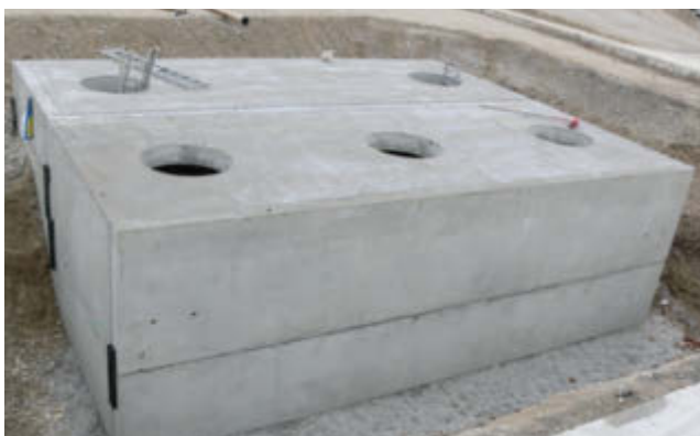
Rigolenanschlussschacht für MAN in München
