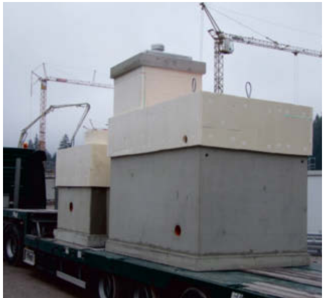
Stahlbetonschächte einbaufertig geliefert mit Dämmung bis ca. 1,0 m unter GOK
