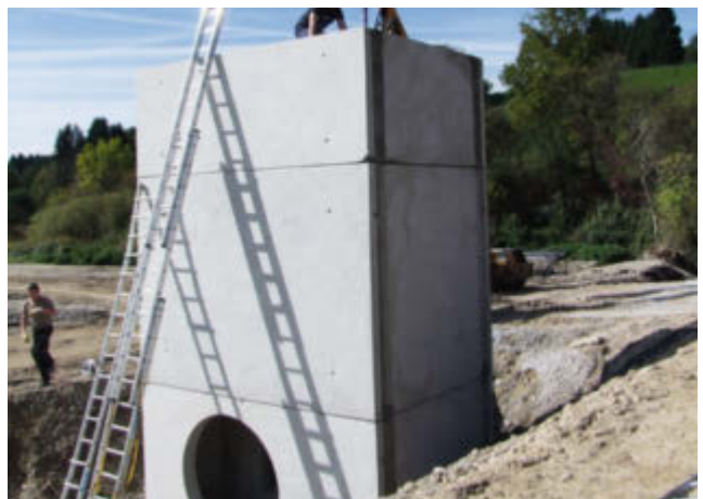
Auslaufbauwerk in Bad Endorf
