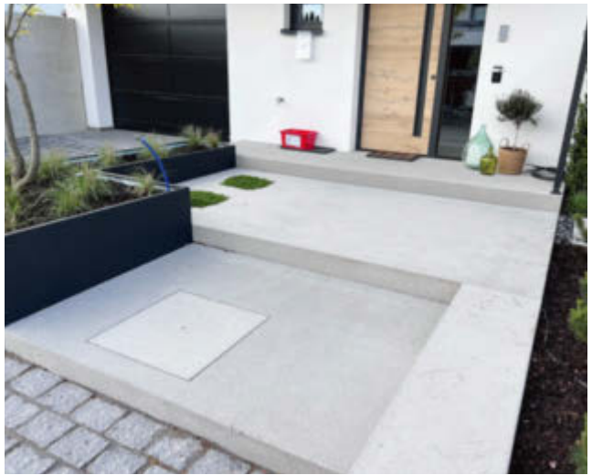
Eingangsbereich mit großen Betonplatten
