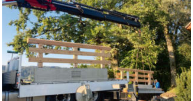
Anlieferung der kompletten Brückenplatte
