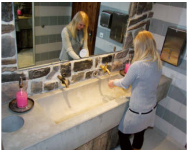
Waschbecken aus Beton
