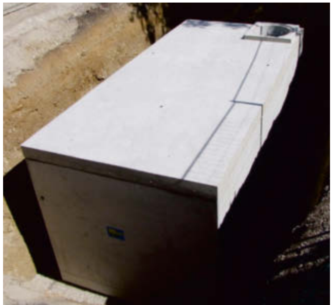
Monolithisch hergestellter Stahlbetonrechteckschacht mit verschiebesicherer Abdeckplatte durch Falzausbildung
