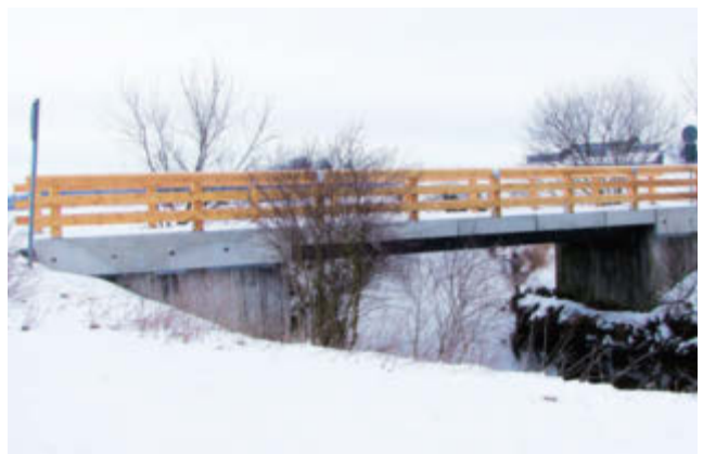
83043 Bad Aibling, Glonnbrücke bei Holzhausen
