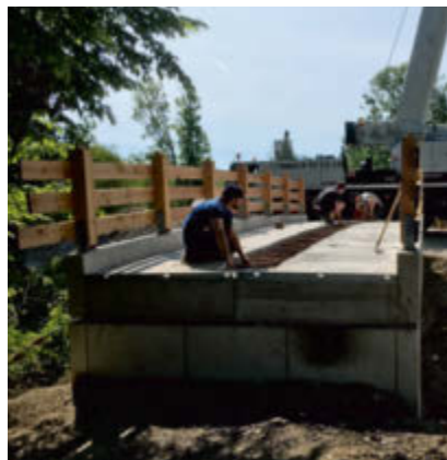
Plattenstoß mit Verschlaufung
